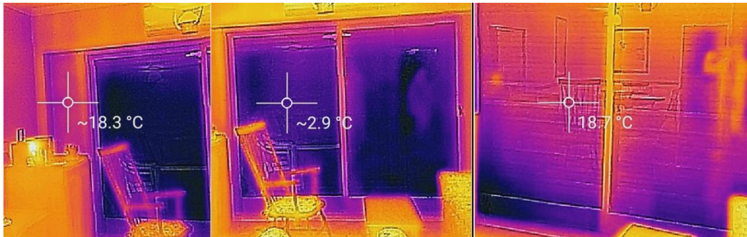
Figura 6. Fotos termográficas de una ventana, izquierda medición de la temperatura de la pared (18,3 °C), medio temperatura de la superficie del vidrio (2,9 °C) y derecha temperatura del vidrio una vez que se cierra la persiana de madera (18,7 °C).
