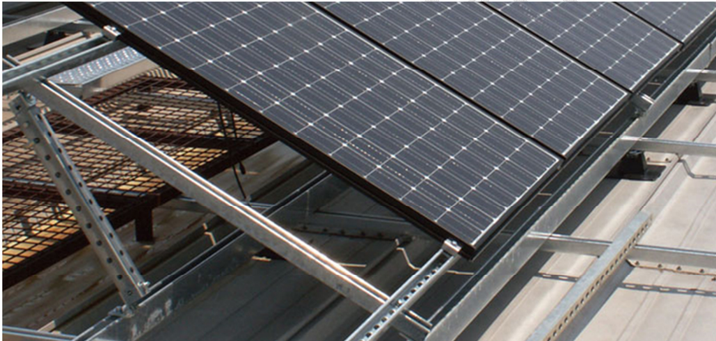
Figura 22: Esquema básico del soporte mecánico de los paneles PV.
