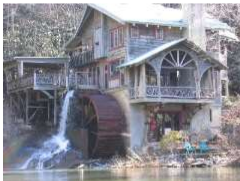
Figura 4. Molino de agua. La energía potencial del agua, se convierte en energía de movimiento del molino.
