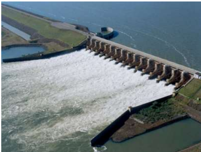
Figura 16. Embalse de Yacyretá. Área cuenca aportante: 970.000 km 2 . Caudal promedio río Paraná: 12.000 m 3 /s. Potencia nominal 3200 MW.
