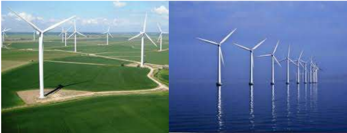
Figura 17. Izquierda, parque eólico “ on-shore ”. Derecha, parque eólico “ off-shore ”.
