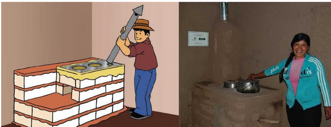
Figura 2. A la izquierda, el esquema de una cocina mejorada en construcción. A la derecha, la cocina construida. Son de muy bajo costo, consumen menos leña y mejoran la salud de los habitantes ya que los gases se van por la chimenea. Además, estas cocinas pueden ser fabricadas localmente por los propios usuarios, quienes se apropian de esta tecnología.
